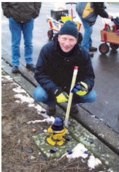
Ulrich Reumke vom Bauhof der Samtgemeinde Sachsenhagen traf die Taxi-Way Beleuchtung
