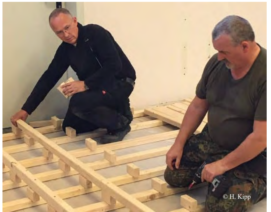
Bei den Umbaumaßnahmen haben Holger Kipp und Klaus Vogtschmidt maßgebend geholfen.
