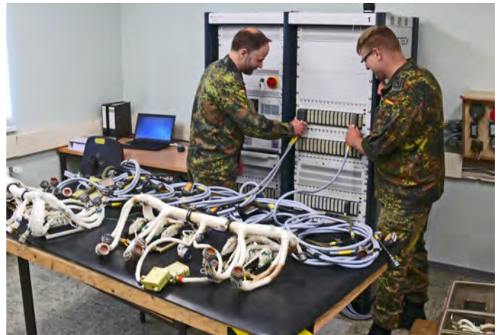
Spezielle Kabelbäume werden ersetzt und vor dem Einbau in das Waffensystem auf Funktionsfähigkeit getestet.
